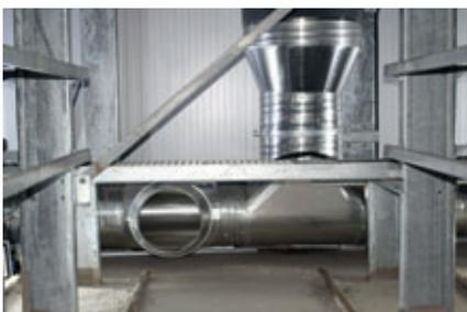
Salida de aire a nivel del suelo de la cámara. Un sistema de circulación eficiente garantiza una circulación uniforme con la mezcla de aire a temperatura exacta.
