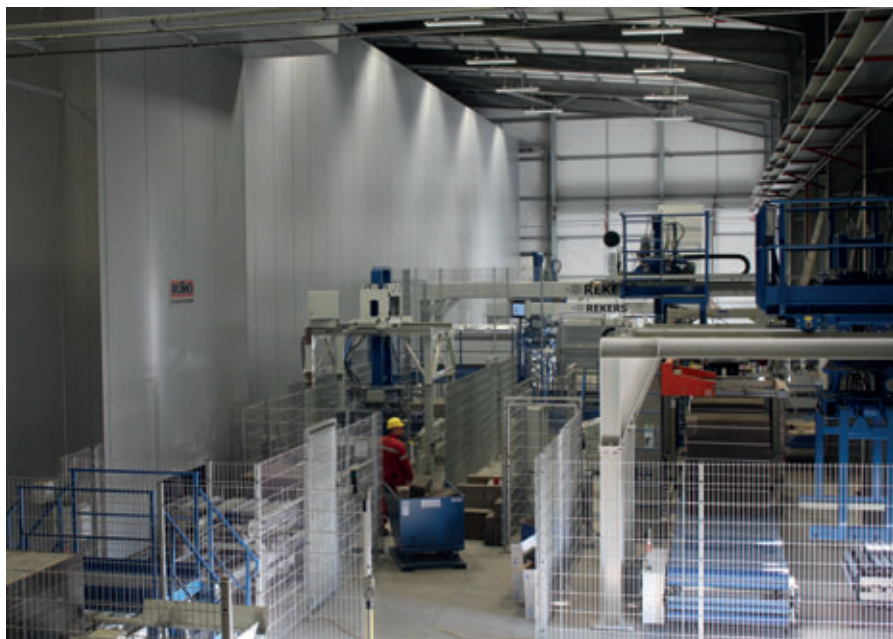
A Rekers também forneceu o equipamento de transporte e de manuseio do lado seco da nova instalação.
