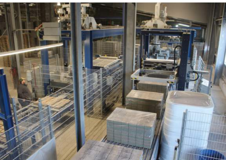
Blick auf die Trockenseite mit Steinlagenübersetzer, Steinschieber, Paketiergerät, Folienaufleger und Umreifungsanlage
