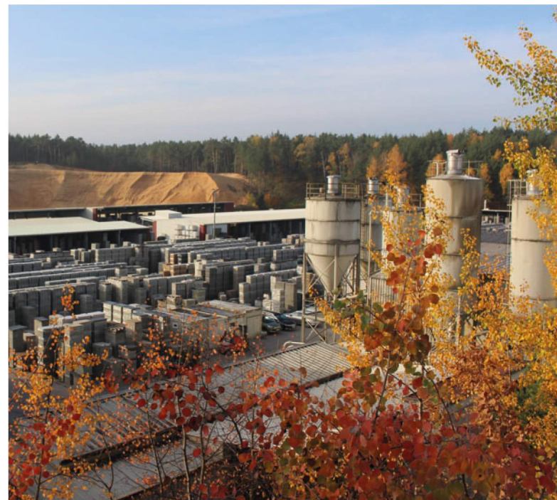
Das Betonsteinwerk von Egner in Neumarkt
